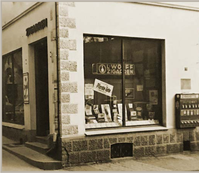
Von 1950 bis in die 1980er Jahre hinein war die Eingangstür zur Gasse – also auf den Lindenplatz ausgerichtet – wie seit der jüngsten Sanierung auch wieder. Das Foto muss nach 1962 entstanden sein.
